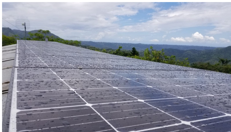
Figura 3. Un total de cinco colmados en barrios distantes fueron energizados con sistemas autónomos fotovoltaicos. Estos lugares representan las primeras líneas de defensa alimentaria para la gente de nuestros campos.
