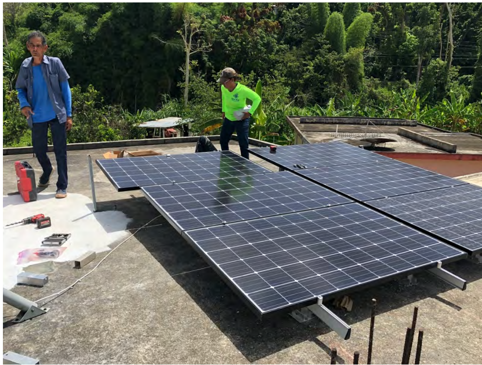
Figura 6. Julio trabajando en el techo de un cucubano.
