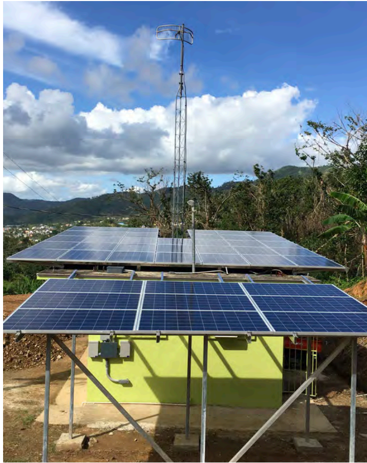
Figura 2. El primer transmisor de Puerto Rico y el Caribe, Radio Casa Pueblo opera sus estudios y la torre de comunicaciones 100% con energía fotovoltaica.
